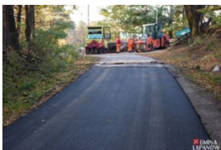
Remont drogi Kobylec-Chrostowa
