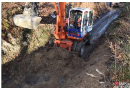
Remont drogi Kobylec – Zagórzany
