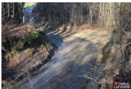
Remont drogi Kobylec – Zagórzany
