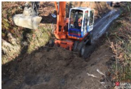
Remont drogi Kobylec – Zagórzany
