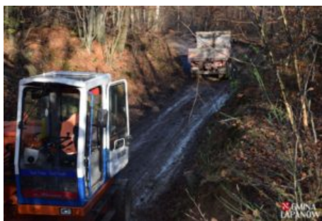
Remont drogi Kobylec – Zagórzany
