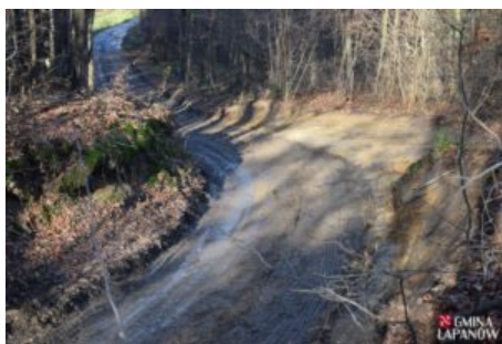
Remont drogi Kobylec – Zagórzany
