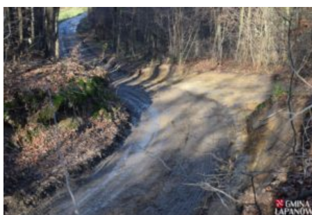
Remont drogi Kobylec – Zagórzany
