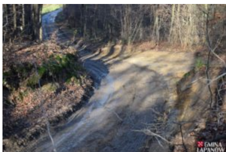
Remont drogi Kobylec – Zagórzany
