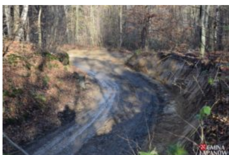
Remont drogi Kobylec – Zagórzany
