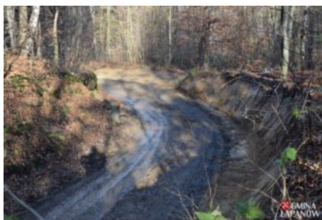
Remont drogi Kobylec – Zagórzany
