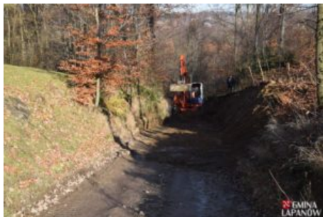
Remont drogi Kobylec – Zagórzany
