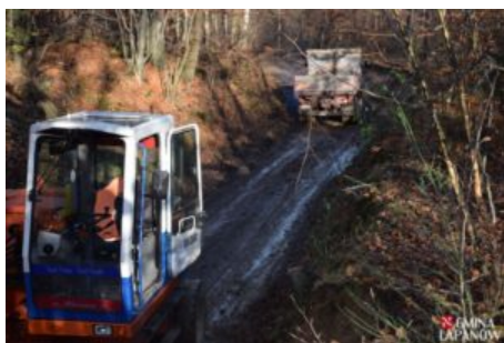
Remont drogi Kobylec – Zagórzany
