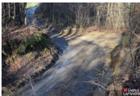
Remont drogi Kobylec – Zagórzany
