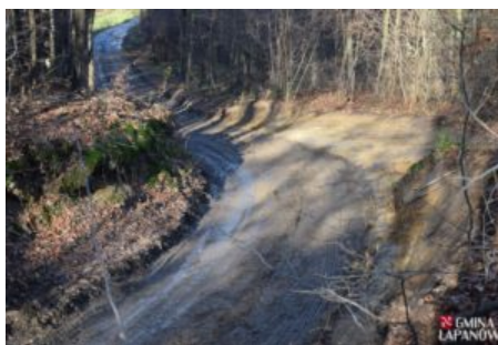
Remont drogi Kobylec – Zagórzany
