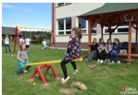
Remonty w szkołach i przedszkolach
