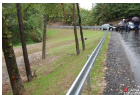
Ustabilizowano osuwisko w Kamyku
