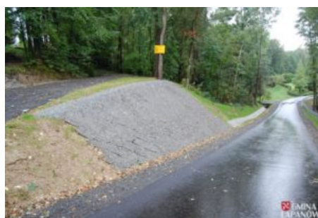
Ustabilizowano osuwisko w Kamyku
