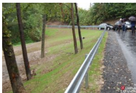
Ustabilizowano osuwisko w Kamyku
