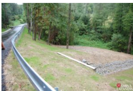
Ustabilizowano osuwisko w Kamyku
