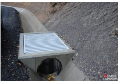
Ustabilizowano osuwisko w Kamyku
