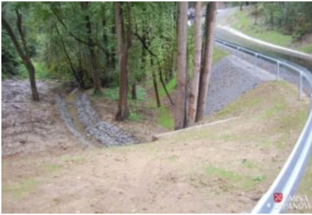
Ustabilizowano osuwisko w Kamyku
