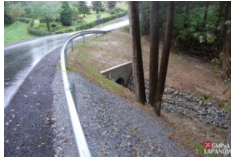
Ustabilizowano osuwisko w Kamyku
