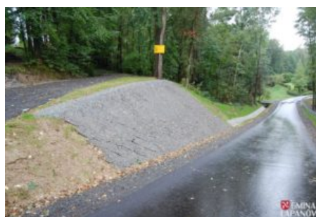
Ustabilizowano osuwisko w Kamyku
