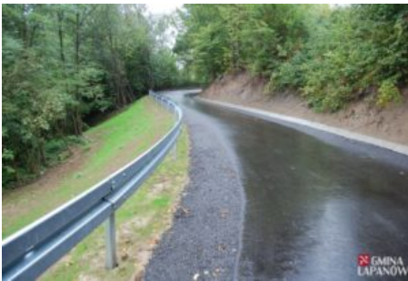
Ustabilizowano osuwisko w Kamyku
