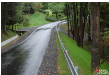
Ustabilizowano osuwisko w Kamyku
