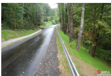
Ustabilizowano osuwisko w Kamyku
