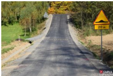
Wyremontowano drogę koło cmentarz
