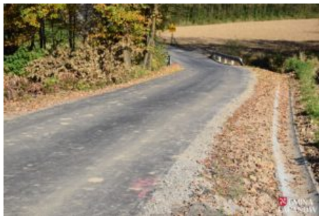
Wyremontowano drogę koło cmentarz
