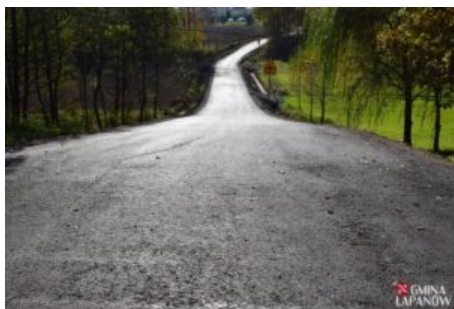
Wyremontowano drogę koło cmentarz
