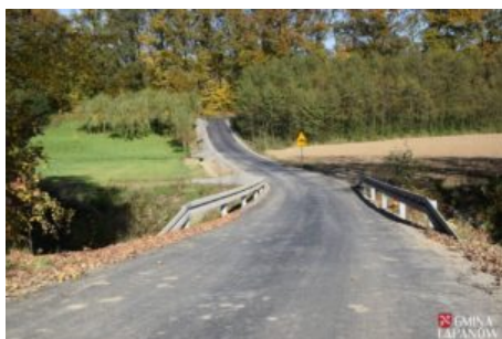
Wyremontowano drogę koło cmentarz
