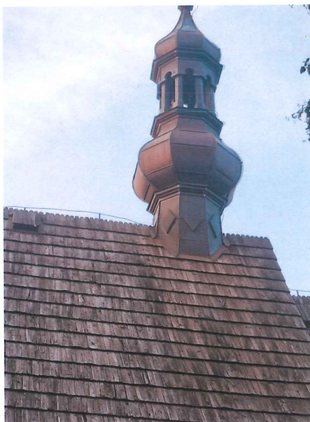
18. WIEŻYCZKA SYGNATURKOWA NAD POŁCIĄ POŁUDNIOWĄ. SPĘKANE I NIESZCZELNE GONTY.
