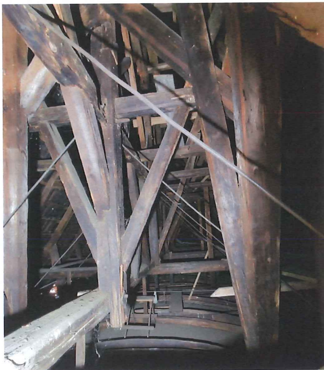
19. RAMA ŚRODKOWA DACHU NA NAWĄ GŁÓWNĄ I SŁUPY POD WIEŻYCZKĘ.
