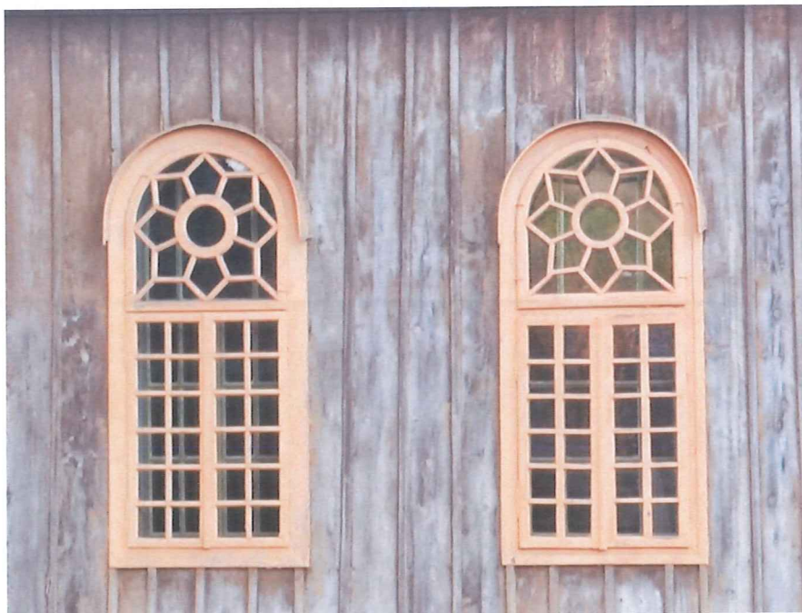
17. WYJAŁOWIONE DESKI OŁACENIA NA ELEWACJI PŁNOCNEJ.
