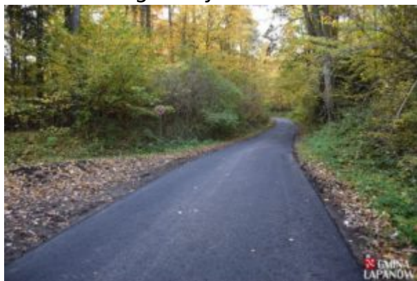
Remont drogi Kobylec-Chrostowa
