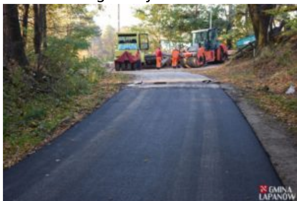
Remont drogi Kobylec-Chrostowa
