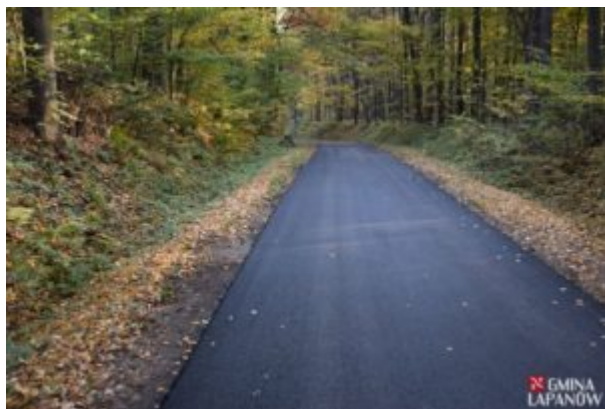
Remont drogi Kobylec-Chrostowa
